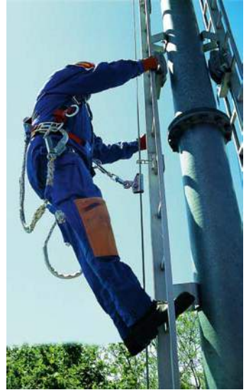
Bild 20: Beispiel einer Steigschutzeinrichtung mit Führung aus Stahldrahtseil
