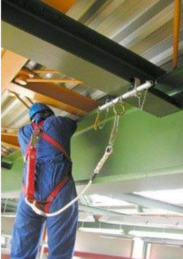
Bild 8: Beispiel eines Auffangsystems mit Falldämpfer
