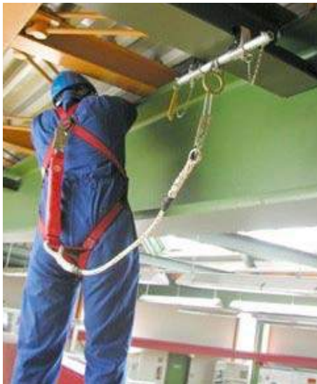
Bild 28: Beispiel für eine Anschlageneinrichtungen der Klasse B - Trägerklemme
