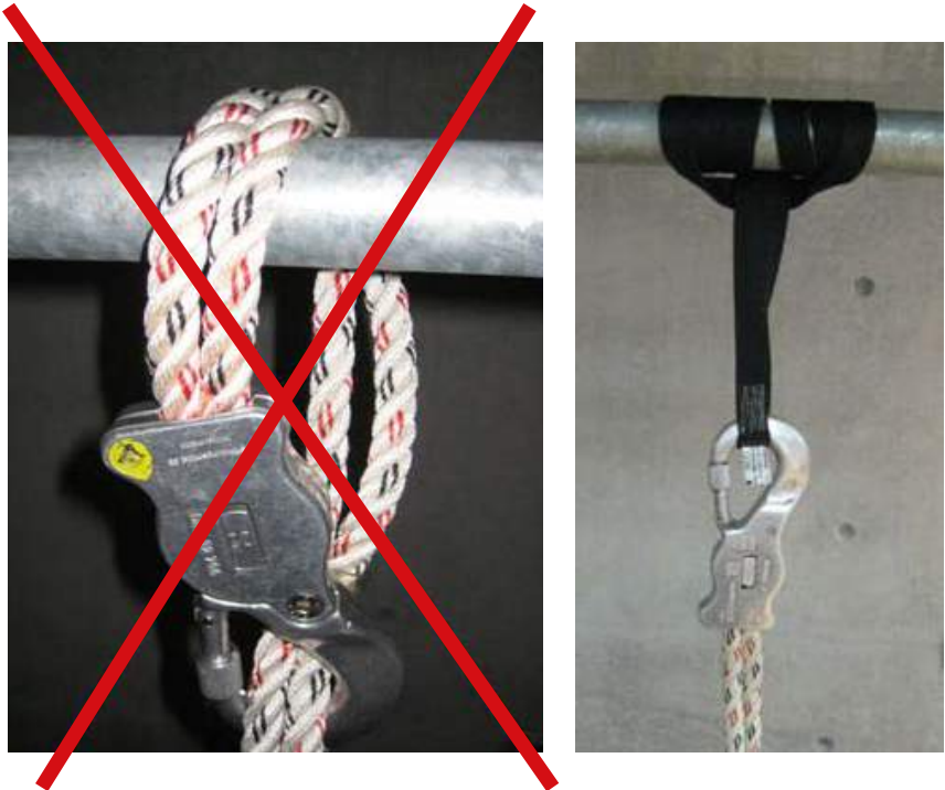
Bild 36: Richtiges Anschlag: Zur Erhaltung der Funktionsfähigkeit des Reibungsfalldämpfers wird eine Bandschlinge als Anschlaghilfe verwendet
