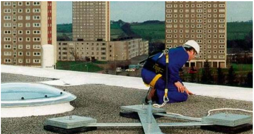
Bild 32: Durch Eigengewicht gehaltene Anschlageinrichtung (z.B. Betongewichte)
